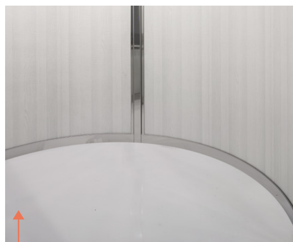
PAVIMENTO In Rocksolid.
